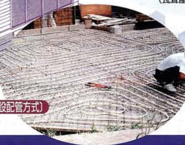
露出配管パイプ方式 (瓦葺屋根)
